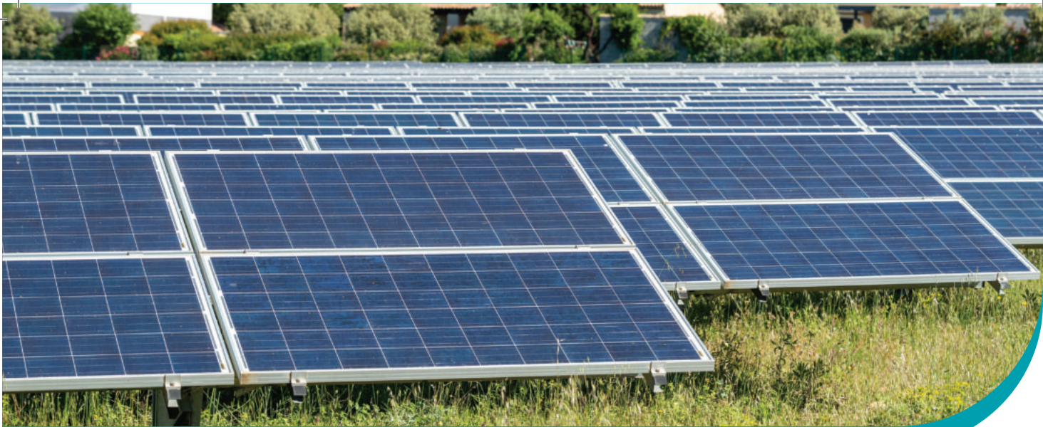
Centrale solaire de La Fare-les-Oliviers
