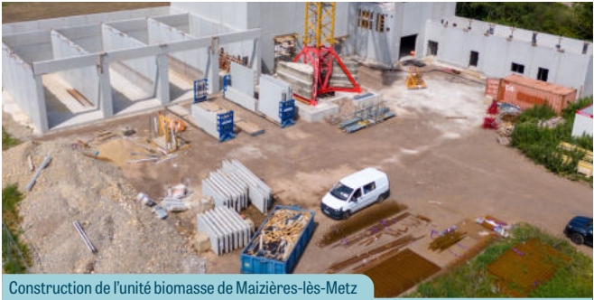
Construction de l'unité biomasse de Maizières-lès-Metz
