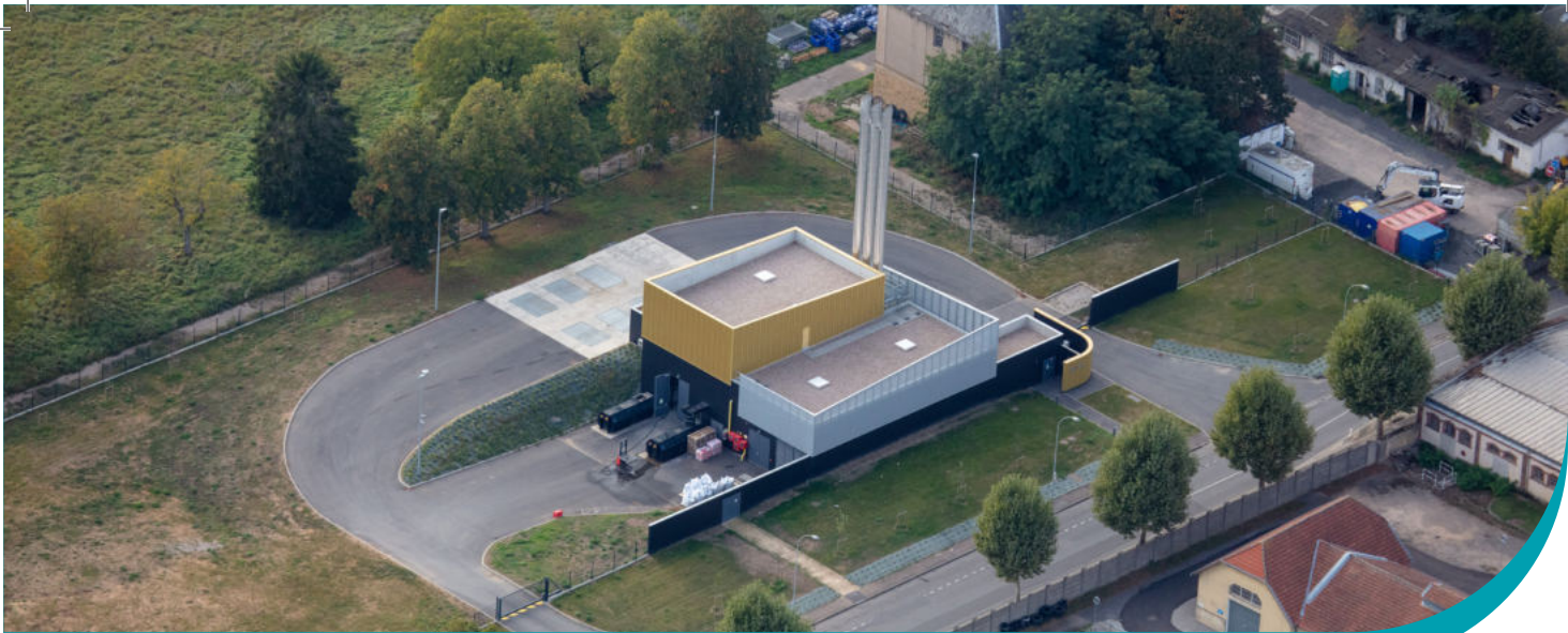
Unité biomasse de Montigny-lès-Metz
