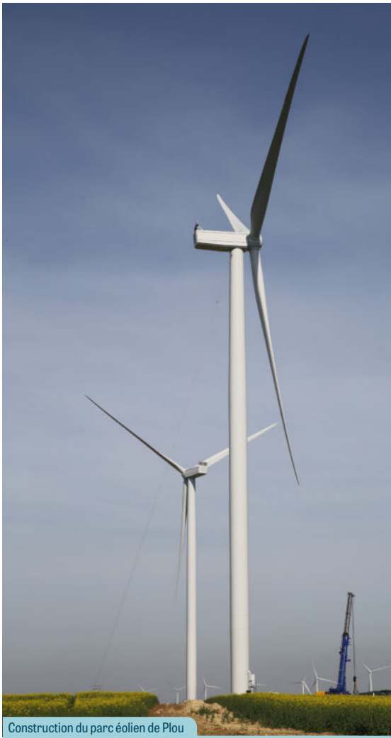
Construction du parc éolien de Plou
